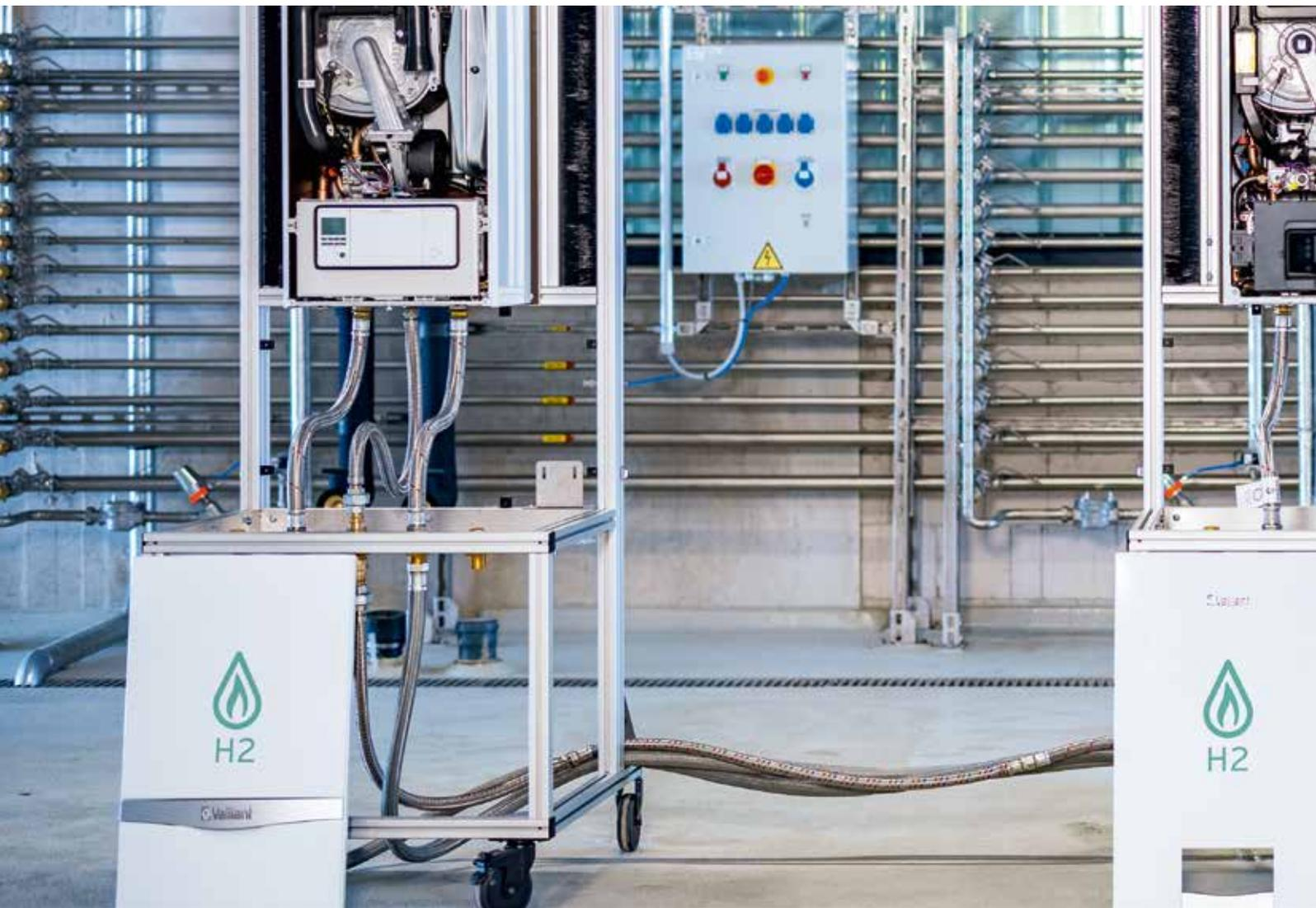
Vaillant Wasserstoff-Brennwertgeräte. Ab der nächsten Heizperiode beginnt die Testphase.
