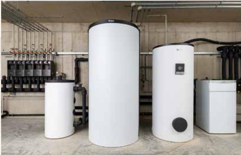
Im Technikraum wurden unter anderem die Wärmepumpe und der Pufferspeicher eingebaut. Ein modernes Reglersystem ermöglicht, alle Räume der Gebäude einzeln anzusteuern.
