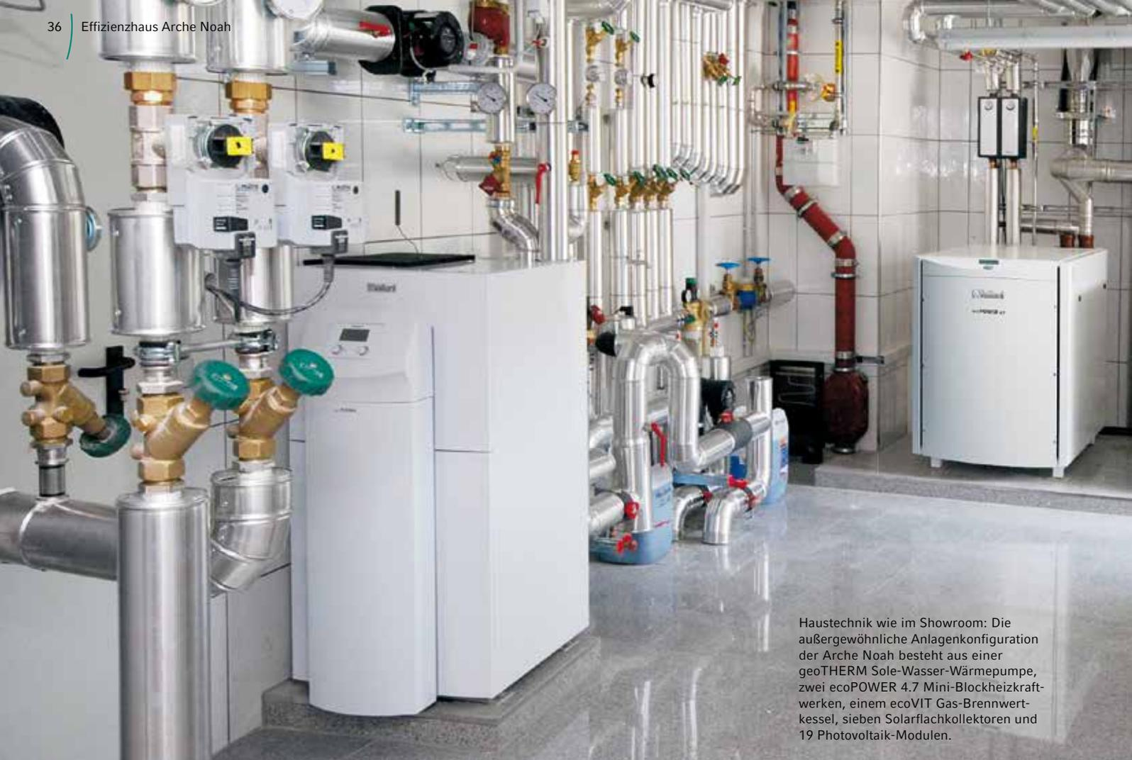
Haustechnik wie im Showroom: Die außergewöhnliche Anlagenkonfiguration der Arche Noah besteht aus einer geoTHERM Sole-Wasser-Wärmepumpe, zwei ecoPOWER 4.7 Mini-Blockheizkraftwerken, einem ecoVIT Gas-Brennwertkessel, sieben Solarflachkollektoren und 19 Photovoltaik-Modulen.
