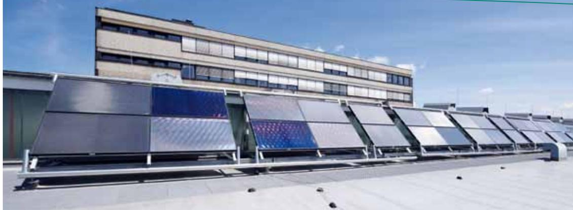
Vaillant Flachkollektoren sorgen für die Warmwasserbereitung in einer Reinigungsanlage des Remscheider Werks.
